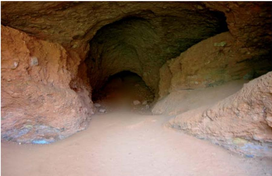
**Figura 11.- Interior de uno de los túneles que se hicieron para hacer circular el agua y descargarla desde lo alto de los estanques en los escarpes, sobre depósitos sedimentos rojos de Las Médulas y así disgregar sus sedimentos y poder separar en ellos los gruesos cantos y arenas, estériles, de la fracción más fina en la que se habrían distribuido los pequeños granos y pajuelas de oro. (En el balcón del alto del mirador de Orellán, agosto de 2006).**
