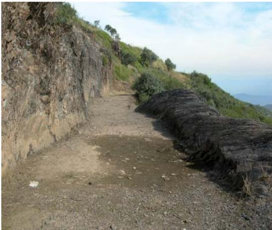
**Figura 10.-** Uno de los canales excavados en las pizarras, en este caso en un lugar cercano al mirador de Orellán. Por él se hizo circular el agua de lluvia caída en los Montes Aquilanos y con ella llenar el estanque situado sobre dicho mirador, también todavía conservado. Como se observa en la fotografía, para poner visible este canal ha sido necesario excavar los derrubios de ladera que lo ocultaban de los que quedan testimonio en el plano lejano de la imagen. (Agosto, 2006).
