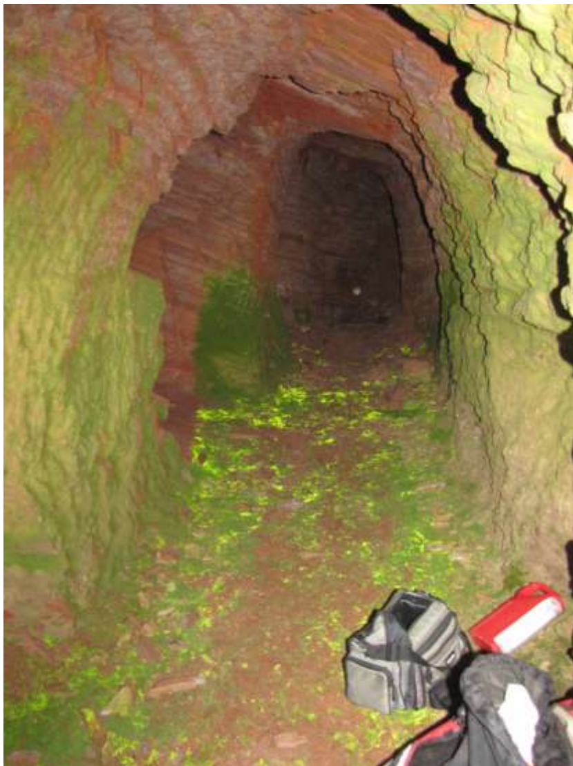
Vista del pasillo principal desde la boca de entrada a la galería.
