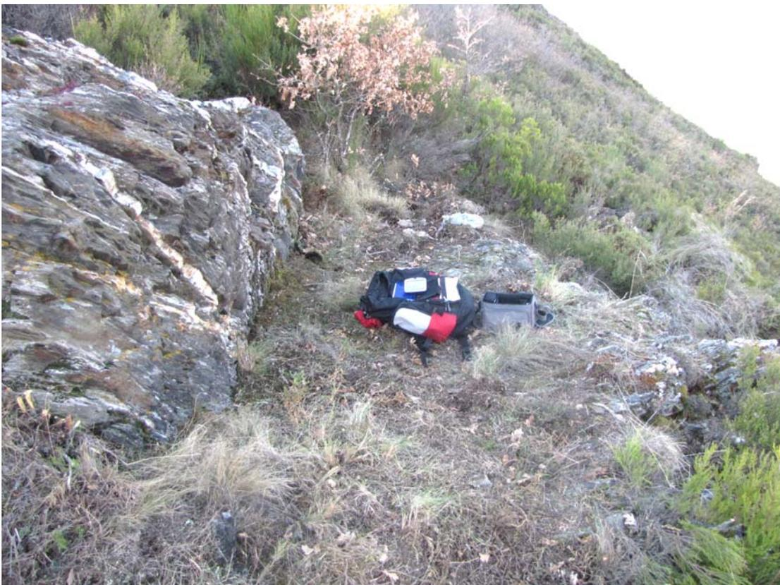
**FOTO G:** En la foto superior se puede observar una vez limpio de vegetación el cajero del canal alto, tallado en roca pizarrosa atravesada por diques de cuarzo lechoso y situado en las coordenadas:
