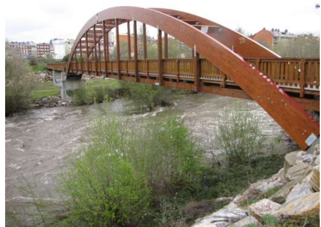
Pasarela peatonal construida en madera en el año 2011, para cruzar el río Sil a la altura de la fábrica de embutidos Pajariel.
