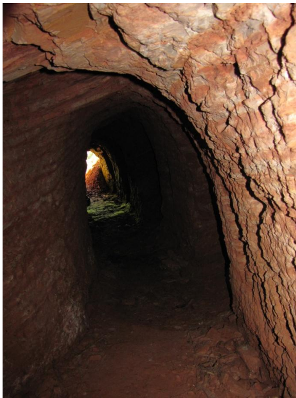
Galería tallada en pizarra muy blanda, de color asalmonado. Se ha interpretado como una “ galería habitacional minera ” dotada de un pasillo de unos trece metros de longitud donde se excavaron, en el flanco izquierdo, seis habitaciones equidistantes.
