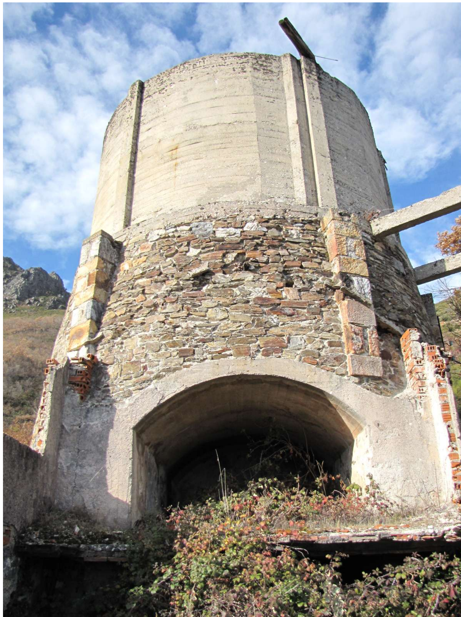
Detalle de la tolva del lavadero inferior. Su robusta construcción, a base de hormigón y gruesos muros de piedra, hace que sea la estructura mejor conservada de todos los edificios dedicados a la actividad minera.
