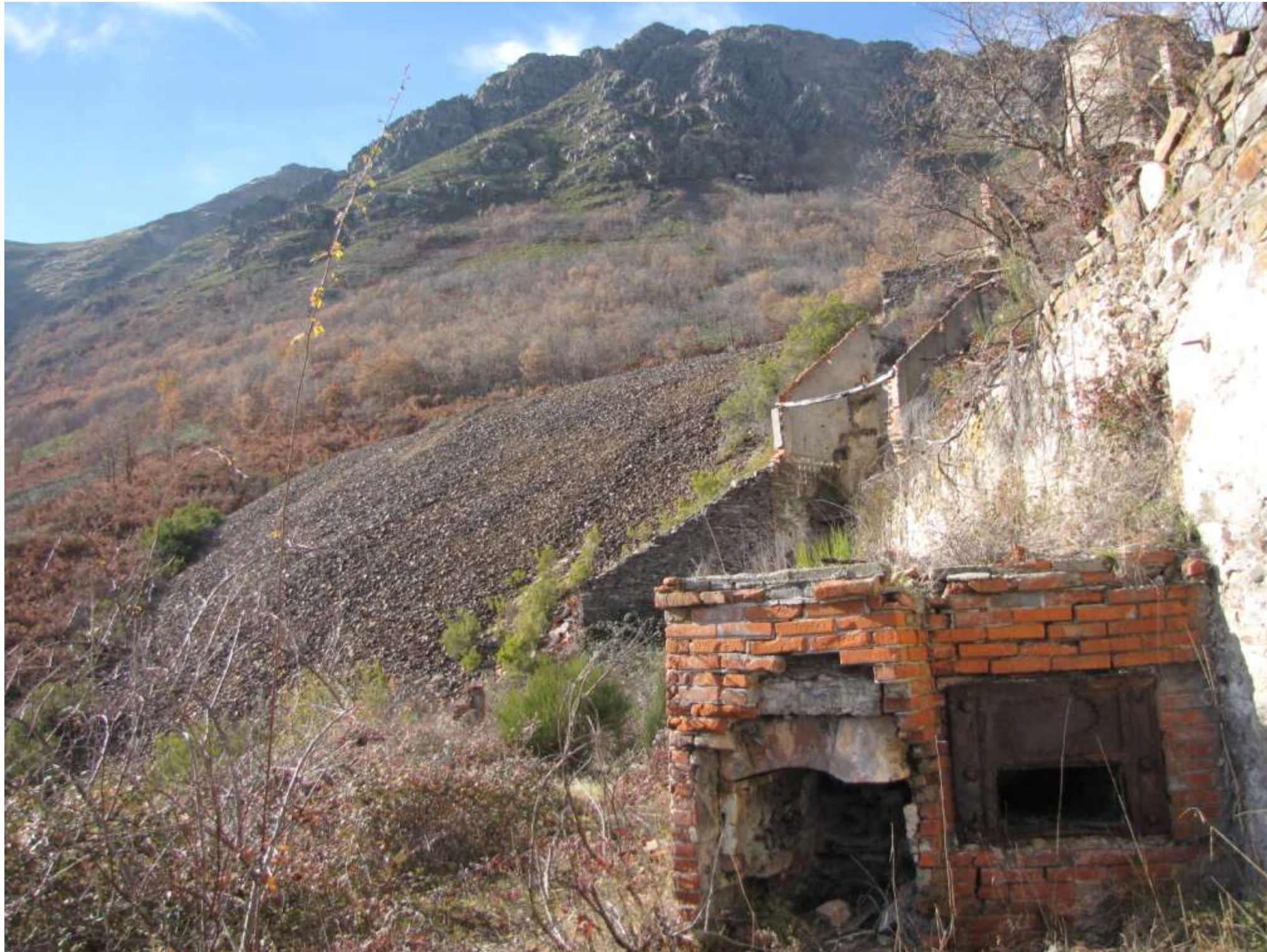
En primer plano, construido en ladrillo y revestido de ladrillo refractario, el horno de calcinación. Fue construido por una empresa del País Vasco y estuvo en actividad hasta su cierre definitivo en el año 1959.
