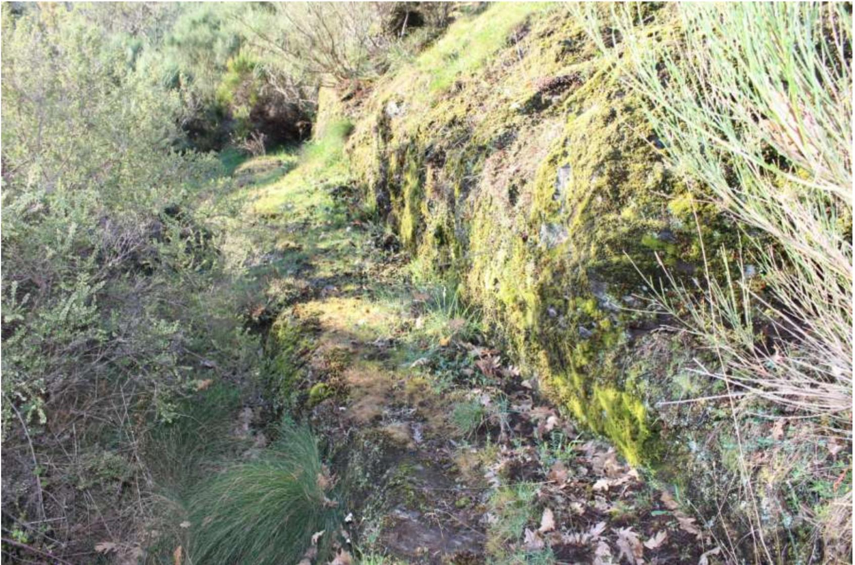
Acequia de conducción de agua con destino a Las Médulas (cota 890 msnm). Se observa como el cajero, tallado en roca, presenta dos niveles, uno para la circulación del agua y el otro, más bajo, para alojar la construcción del hastial.
