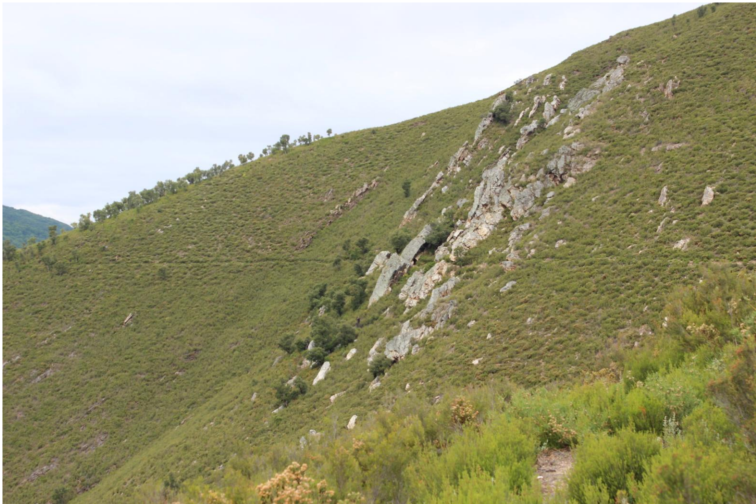
Perspectiva de la traza del canal atravesando, mediante un túnel, un paquete de duras cuarcitas en el paraje de Valdecucrillos
