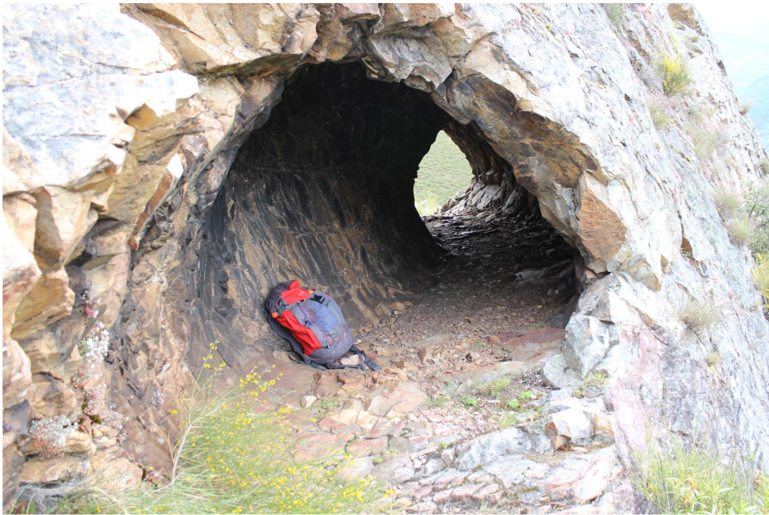
Túnel conocido como “Buraco de Valellos”. Atraviesa un duro paquete de cuarcitas acostadas adaptándose a la forma del pliegue. Se trata de uno de los túneles de trazado más singular de toda la red hidráulica.
