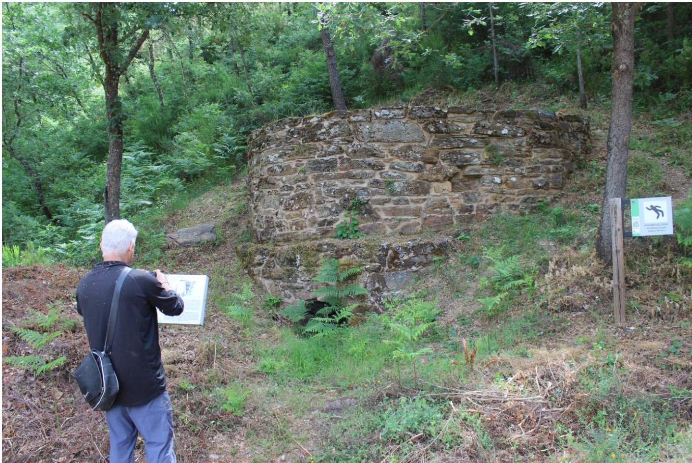
Aspecto del horno de calcinación de la conocida como Ferrería de Godoy. En él se sometía el mineral a altas temperaturas para extraerle la humedad y eliminar carbonatos, azufre, etc., al objeto de enriquecer la ley mineral de hierro antes de entrar en el hogar.
