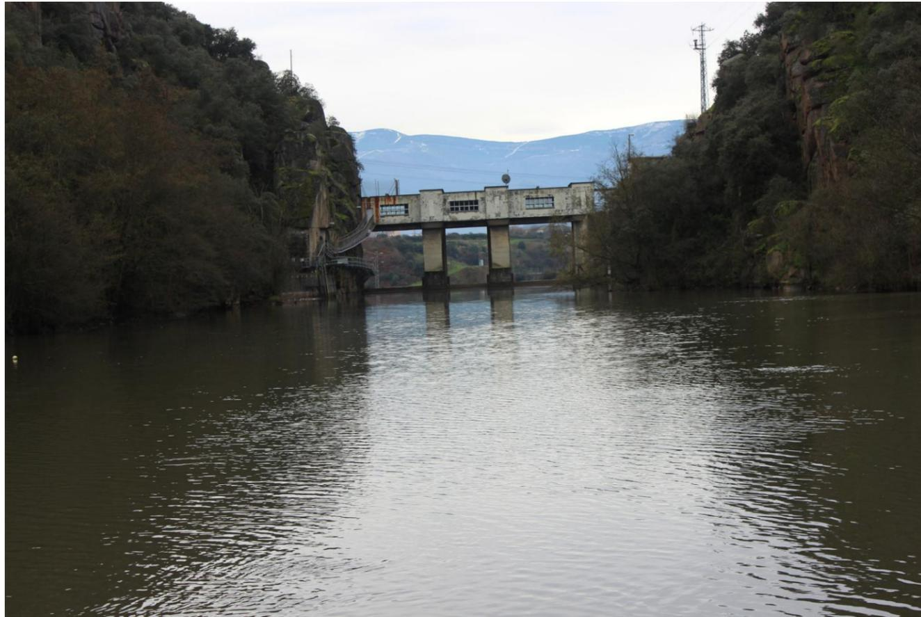
Vista de la presa de Fuente del Azufre desde la lámina de agua. Fue puesta en servicio en 1948 con el objetivo de proporcionar agua de refrigeración a la central térmica de Compostilla I. Actualmente se utiliza para derivar agua a la central hidráulica de Cornatel, proporcionar riegos a través del canal bajo del Bierzo y dotar las servidumbres del río Sil a su paso por Ponferrada.
