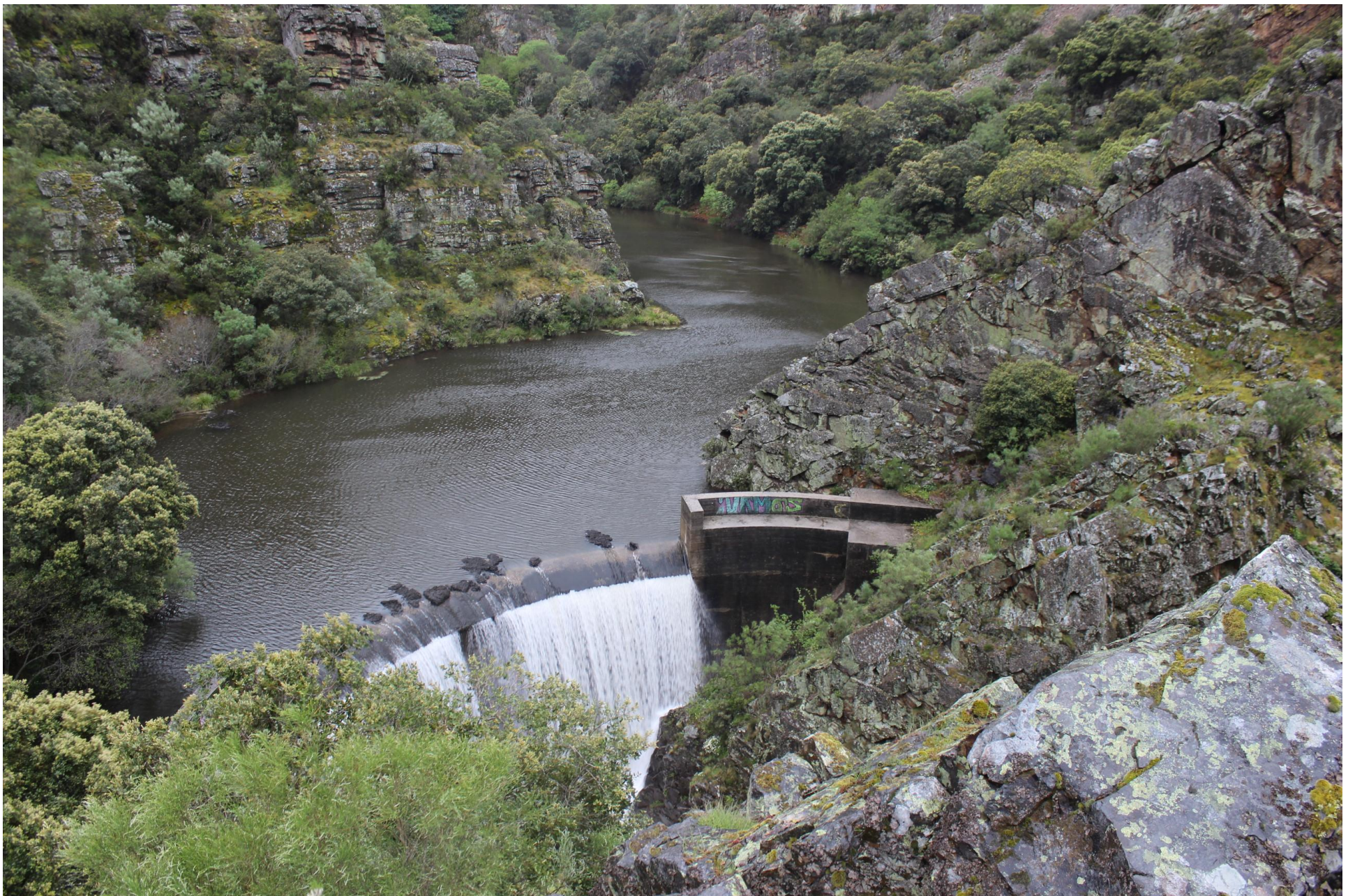
Durante el itinerario rebasamos la presa de San Facundo
